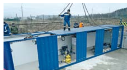
Die Logistiker lieferten die Container nicht nur an die Baustelle, sondern direkt bis in die Baugrube.
