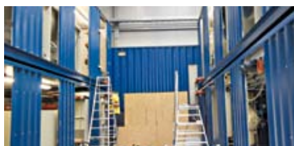
In der Halle wurden die Container auf die Maße der Wasseraufbereitungsanlage „zugeschnitten“.
